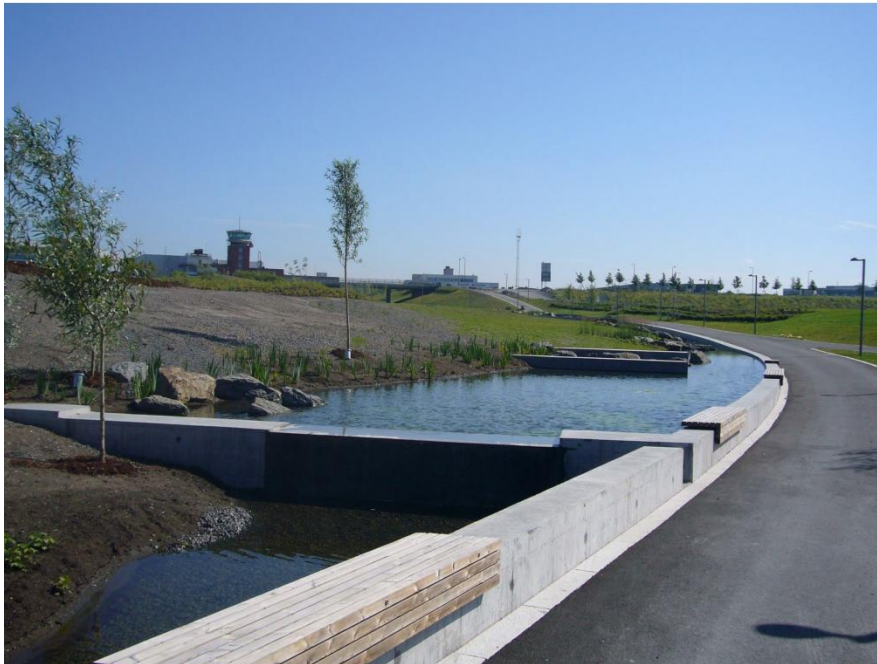
Figur 25. En skyddsvall som stoppar dagvatten från att nå en vägyta. (Overfaltevann som ressurs, Eksempel fra Fornebu, 2009, Johan Steffensen, Baerum kommune)
