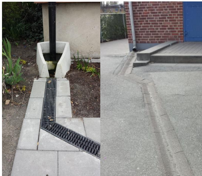
Figur 14. Fler inspirationsbilder för grunda rännor för stuprör med utkastare (foto: Ramböll)
