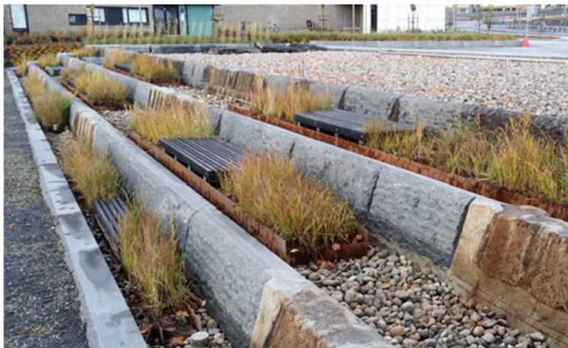
Figur 17. Exempel på filter och fördröjningsanläggning i lutande terräng (foto: Ramböll).
