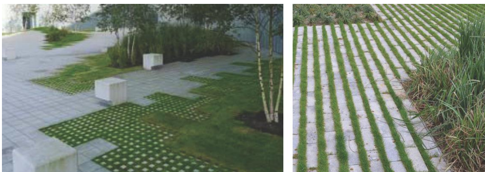
Figur 21. Illustrationsbilder över genomsläppligt ytmaterial i form av gräsarmering. (Konceptbilder Landskap, Hårdgjord grönska, White arkitekter, 2016)
